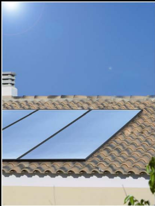
Pueden apreciar la instalación de una batería compuesta de tres captadores, realizada sobre tejado inclinado.
